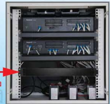
รางปลั๊กไฟ PDU กันฟ้า เต้ารับด้านหลัง
